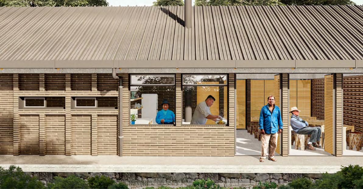
Cubierta metálica, con canaletas y bajantes se hace recolección de agua; los muros son en bloque de tierra comprimida.
