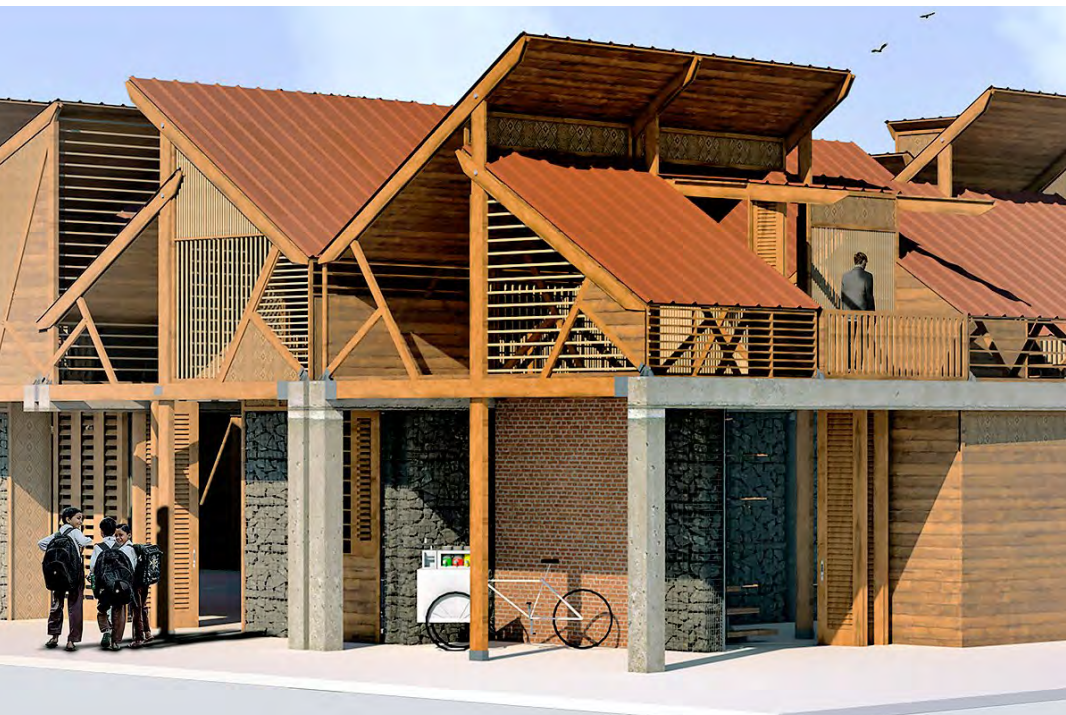
Sistema portante combinado: estructura principal en concreto complementada con madera.
