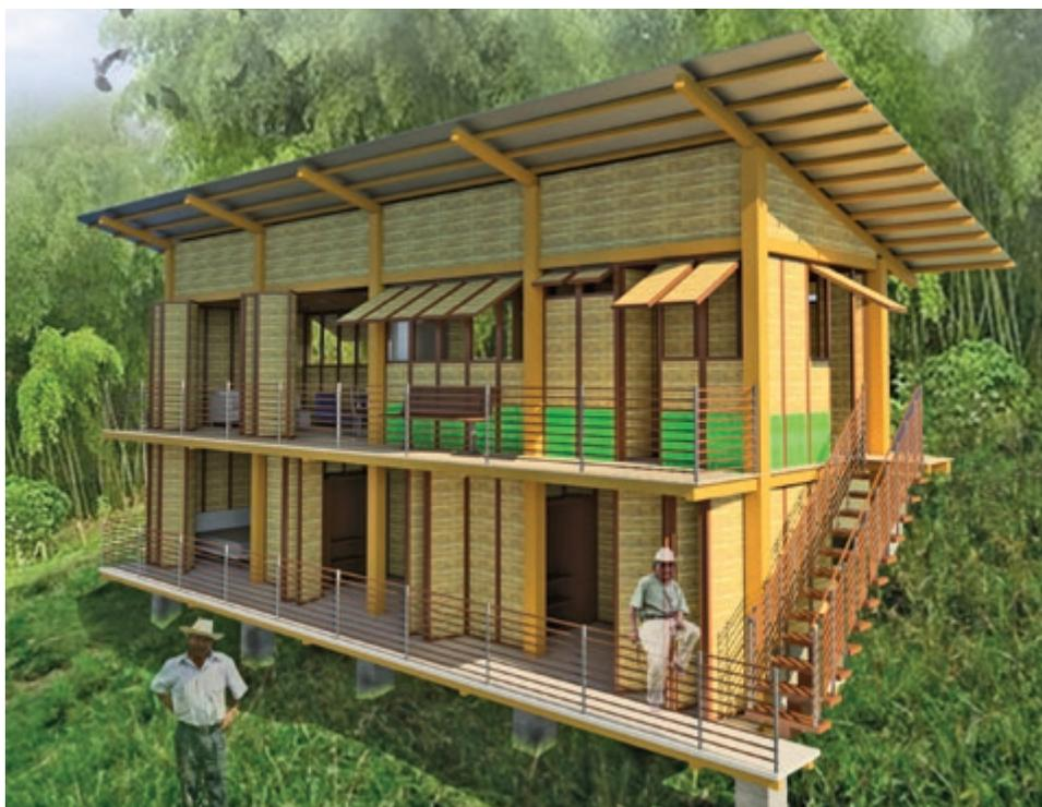
▲ Vivienda con agrupación compacta lineal de módulos en terreno inclinado, que crece en un segundo nivel.
