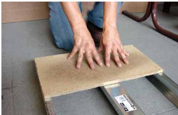
■ Montaje del tablero en la estructura
