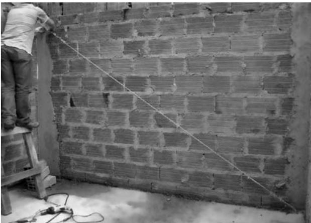
▲ Tensionamiento del cable rigidizante.
