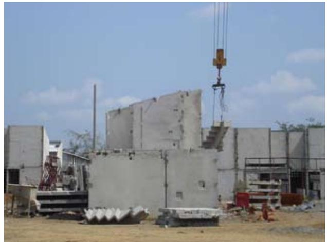
▲ Montaje de los paneles prefabricados en la obra.
