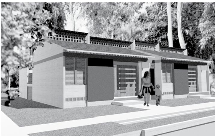
Para las puertas ventanas se utilizan marcos y bastidores de lámina doblada pintada y vareta de *madera plástica* con sección de 2,5 x 12 cm, material que se obtiene de la planta recicladora ubicada en San Pelayo, Córdoba (a 20 minutos de Montería) y que se abastece de material plástico de desecho de la región.
