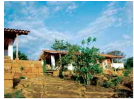
▼ ▲ Cañada entre las dos construcciones que desemboca en la poceta
